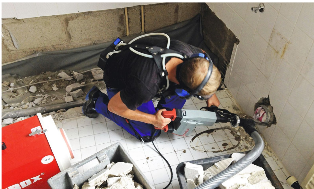
1 Abbruchhammer mit abgesaugtem Quermeißel im Einsatz, links ein Luftreiniger (Dustbox). Der Fliesenleger hat am Gürtel zwei Pumpen, die Luft in der Nähe des Gesichtes absaugen und auf einem Filter zur Analyse sammeln.
