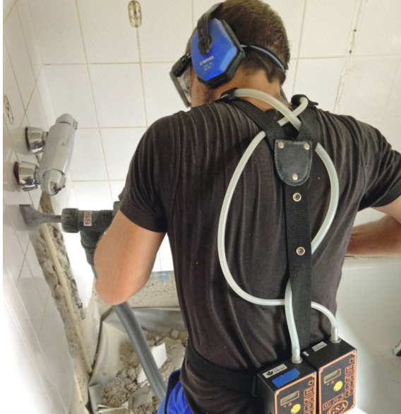
3 Abbruchhammer mit abgesaugtem Quermeißel im Einsatz.
