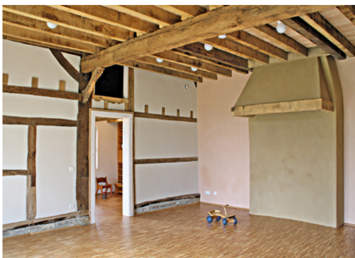
2 Auch die Esse der rekonstruierten Kaminanlage besteht aus mehreren Lehmlagen.
