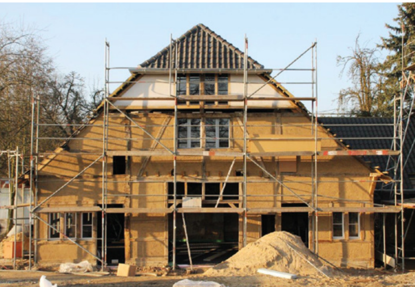
4 Das Giebfeld ist schon mit Kalk verputzt, während unten noch der Lehm-Unterputz zu sehen ist. Foto: Martin Breidenbach
