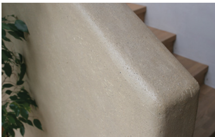
3 Detail des Geländers: der Unterputz wurde mit punischem Wachs eingelassen.
