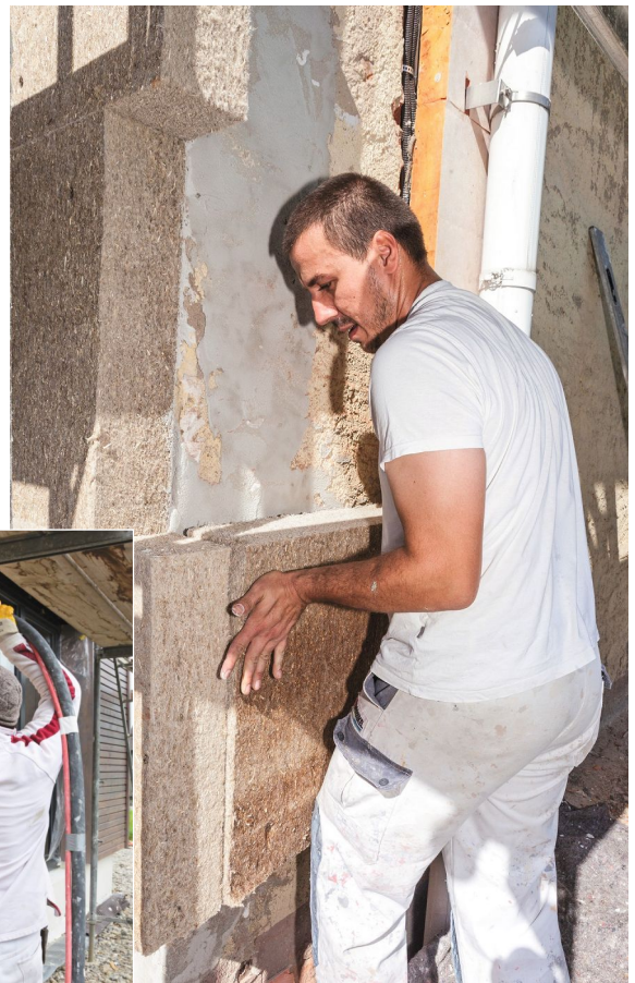
3 ... und Dämmstoff aus Hanf, einem nachwachsenden Rohstoff. Foto: Caparol
