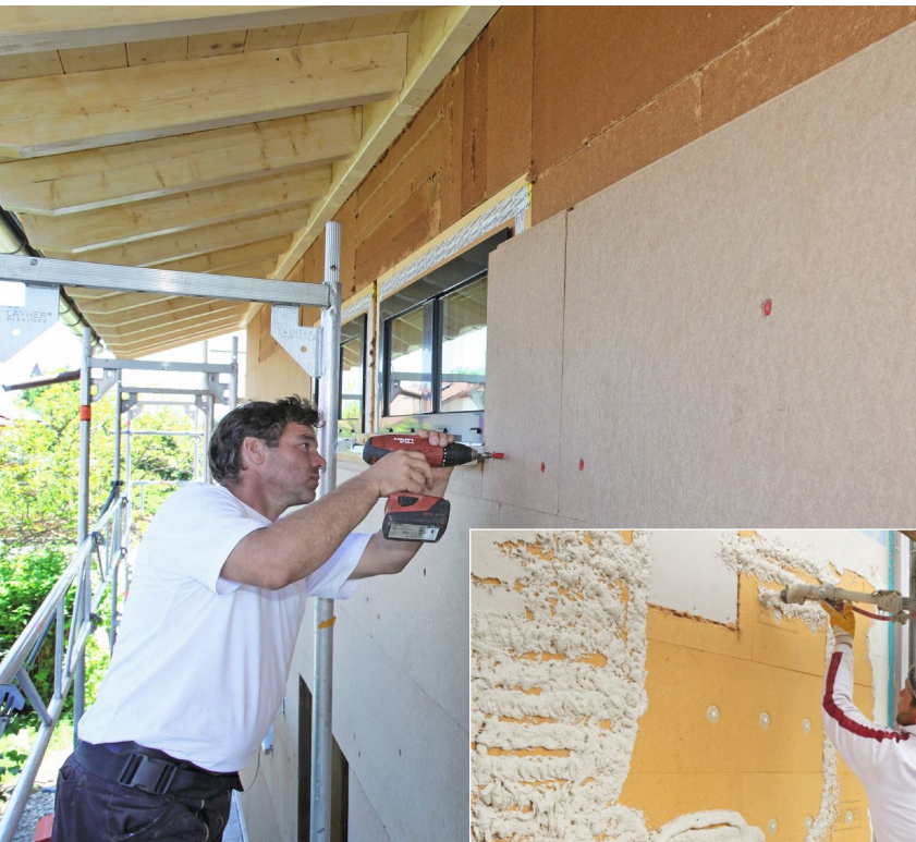
1 + 2 Produkte aus nachwachsenden Rohstoffen anstatt aus fossilen Ressourcen: Dämmung mit Holzfaserplatten ...
