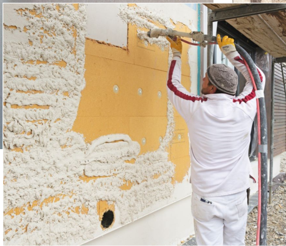
3 ... und Dämmstoff aus Hanf, einem nachwachsenden Rohstoff. Foto: Caparol
