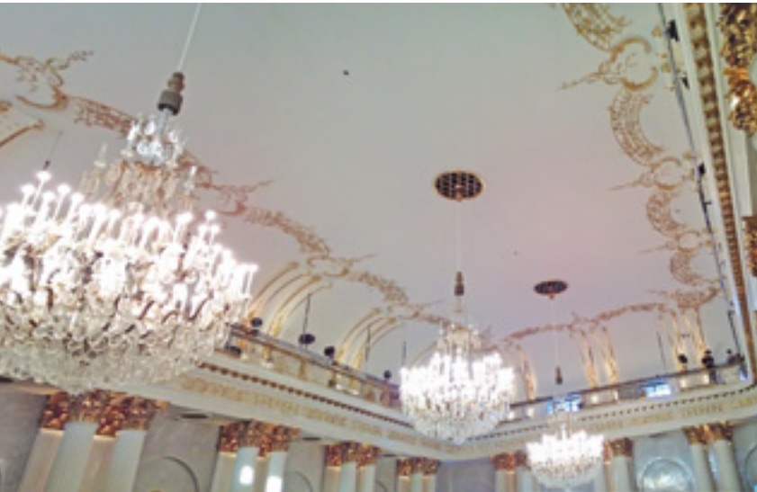
1 + 2 Staatsoper Unter den Linden nach der Generalsanierung. Akustikputzdecke unter einer Rabitzdecke.
