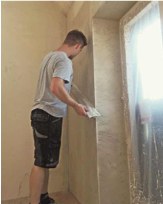
5 Wie macht man einen Innenputz? Der Stuckateur erklärt Schritt für Schritt.
