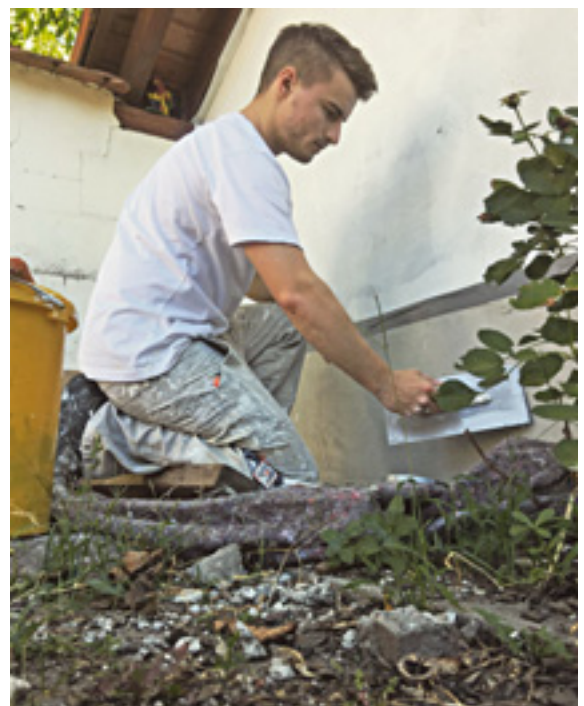
2 Bild von der Baustelle: So wird ein Sockel gefilzt.
