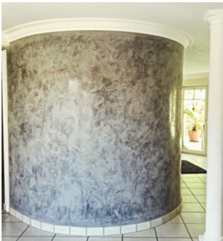
4 Referenz auf Instagram: Die Wand wurde glatt (Q4) gespachtelt und anschließend eine spezielle Spachtelmasse aufgetragen.
