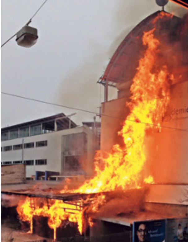
München: Flammhöhe 12 m bei Brand eines leeren Holzschuppens, Fassade ungedämmt. Was wäre bei einer gedämmten Fassade anders gewesen?
