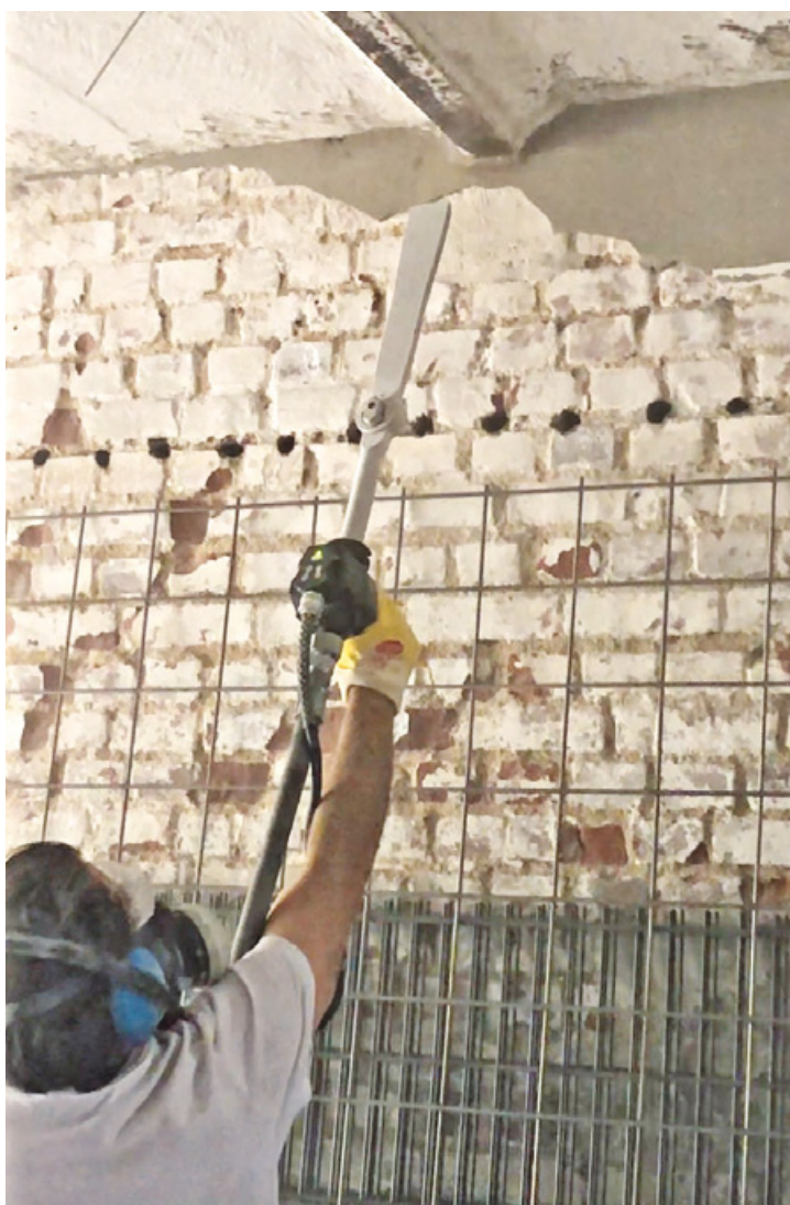
2 Atemschutz ist vor allem in schlecht gelüfteten Umgebungen beim Eisstrahlen sinnvoll. Foto: Jörg Ottemeier
