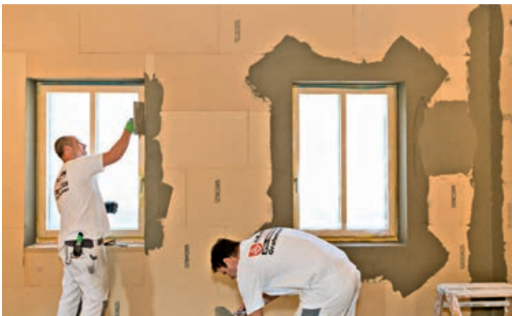
7 Spachtelarbeiten vor der Aufbringung des Oberputzes.
