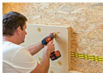
1 + 2 Innendämmung mit Thermoroom Holzfaserdämmplatten, hier auf einer schlagregengeschützten Holzunterkonstruktion geklebt und verdübelt.
