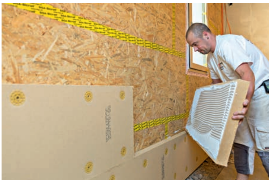
1 + 2 Innendämmung mit Thermoroom Holzfaserdämmplatten, hier auf einer schlagregengeschützten Holzunterkonstruktion geklebt und verdübelt.
