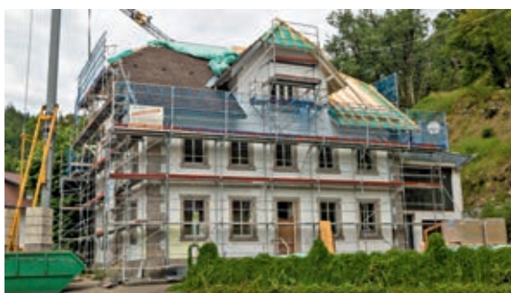
3 Die erste Baustelle mit der RAL-Innendämmung in Witznau/Schwarzwald.
