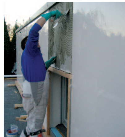
7 + 8 Hölzerne Lehrgerüste sicherten die großformatigen Glaselemente bis zum Abbinden des Klebers vor dem Abrutschen. (Fotos 3 - 7: Saint-Gobain Weber)
