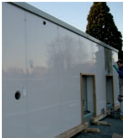
7 + 8 Hölzerne Lehrgerüste sicherten die großformatigen Glaselemente bis zum Abbinden des Klebers vor dem Abrutschen. (Fotos 3 - 7: Saint-Gobain Weber)
