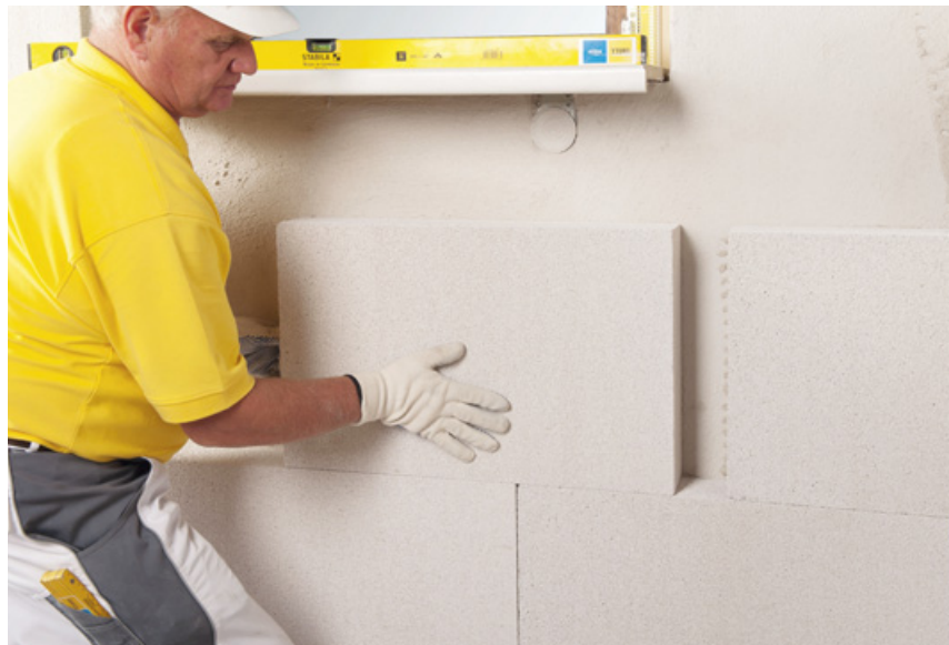
3 Innendämmung kann mit Platten erfolgen. Foto: Ytong Multipor
