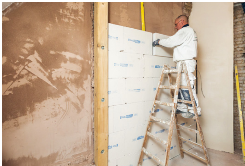
4 Die Vermeidung von Hinterströmung ist wichtig. Foto: Knauf
