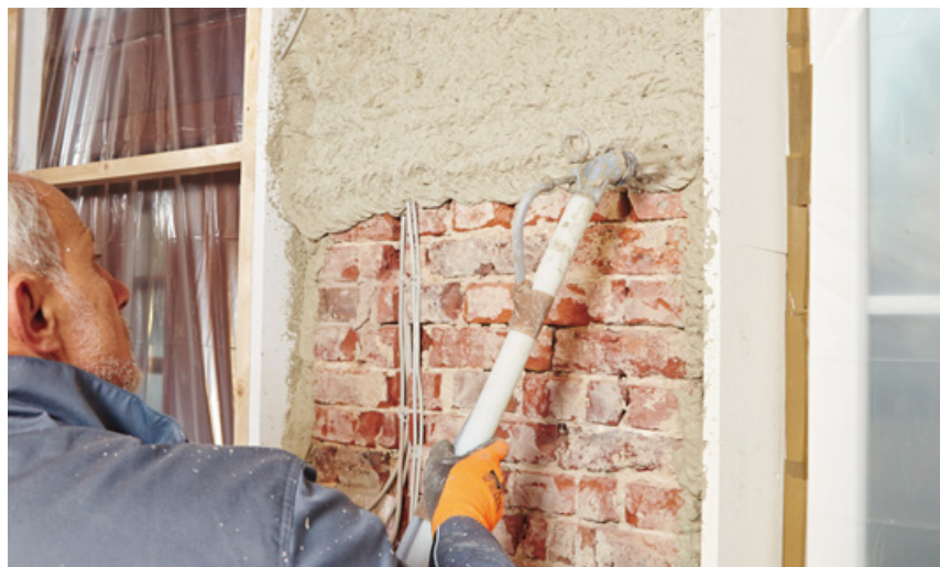
5 Dämmputz ist eine platzsparende Option. Foto: Sievert
