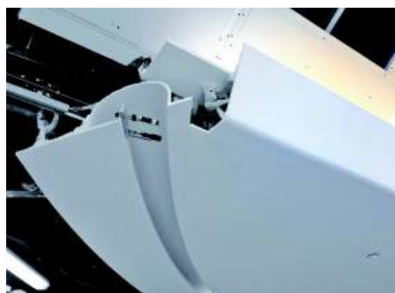
2 + 3 Die Formteile haben eine Länge von 250 cm und eine Breite von 60 cm und sind in unterschiedlichen Radien gebogen, die Aufhängung erfolgte mittels Drahtseilen.
