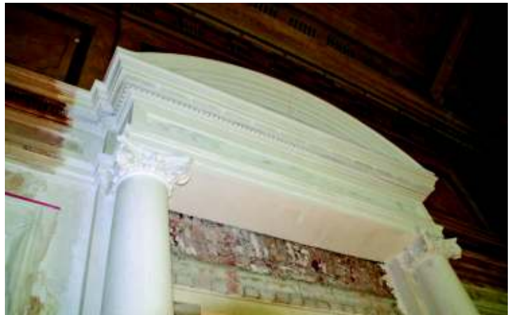
1 + 2 Palmengarten Frankfurt am Main: Rekonstruktion von Stuckelementen im Modularverfahren. Unten: Bei der Wiederherstellung des Portals konnte durch die Vorfertigung die Montagezeit stark verkürzt werden.
